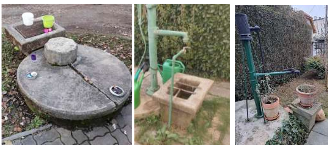
Slike 53, 54, 55: Betonski podstavki za vedra (Vir: lastne fotografije)
